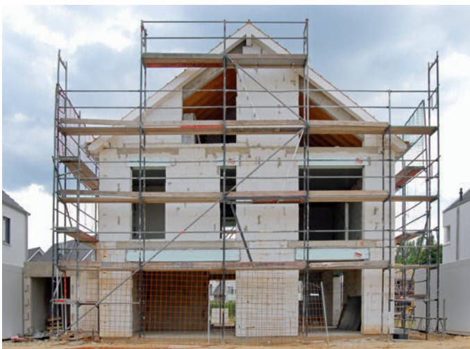
Das Bau-Kapitel enthält richtige Investitionsanreize, bspw. ein „Baukindergeld“.
